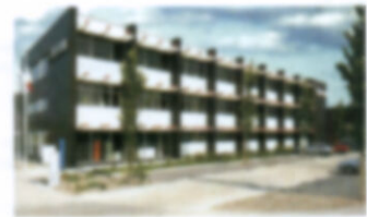
Telecom B.V. in Rotterdam. (Foto: Aerocom)
